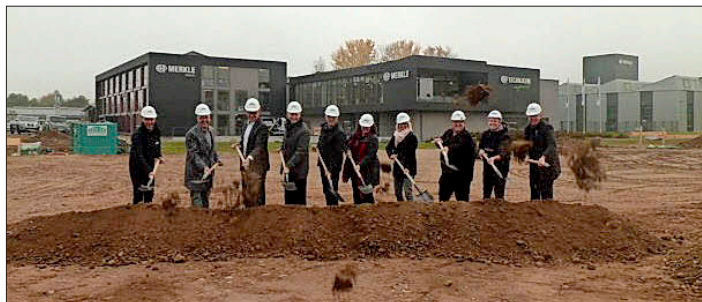
Der erste Spatenstich (von links): Bauunternehmer Stefan Gruber, Architekt Klaus Wehrle, Jörg Dehler (Volksbank Breisgau-Markgräflerland), Axel Karrer, ein Mitarbeiter der Firma Gruber sowie Kathrin Mönig von AHP Merkle, Katrin Merkle, Christen Merkle, Tim Merkle und Bürgermeister Riesterer. Foto: mwo
