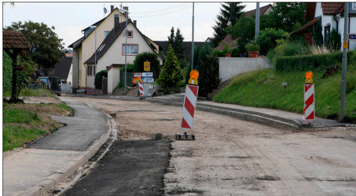
Die Fertigstellung der oberen Hauptstraße in Gottenheim steht kurz bevor. Mitte Juni soll die Straße wieder offen sein.
