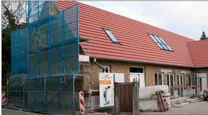
Die Sanierung von St. Stephan in Gottenheim kommt voran.
