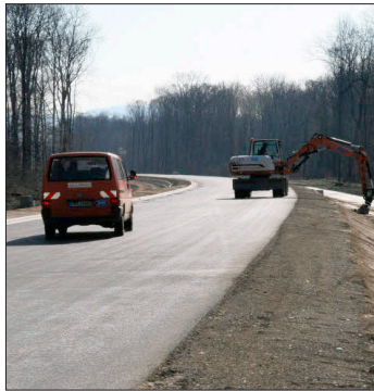
Der Bauabschnitt der B-31 zwischen March und Gottenheim steht unmittelbar vor der Fertigstellung. Foto: ma
