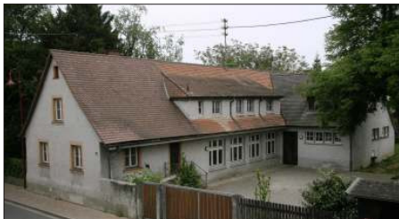
Das Gemeindehaus St. Stephan soll ab Herbst saniert werden. Der Erlös aus dem Café-Treff am Sonntag wird für die Sannierung gespendet. Fotos: ma
