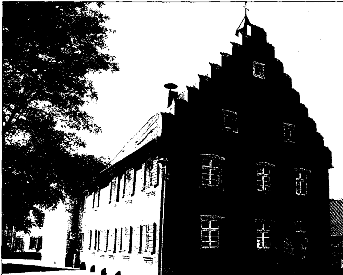
Das Rathaus in Gottenheim wurde in den Jahren 2001 bis 2002 saniert.
