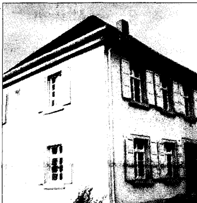
Die Fassade des Pfarrhauses muss ebenfalls saniert werden.
