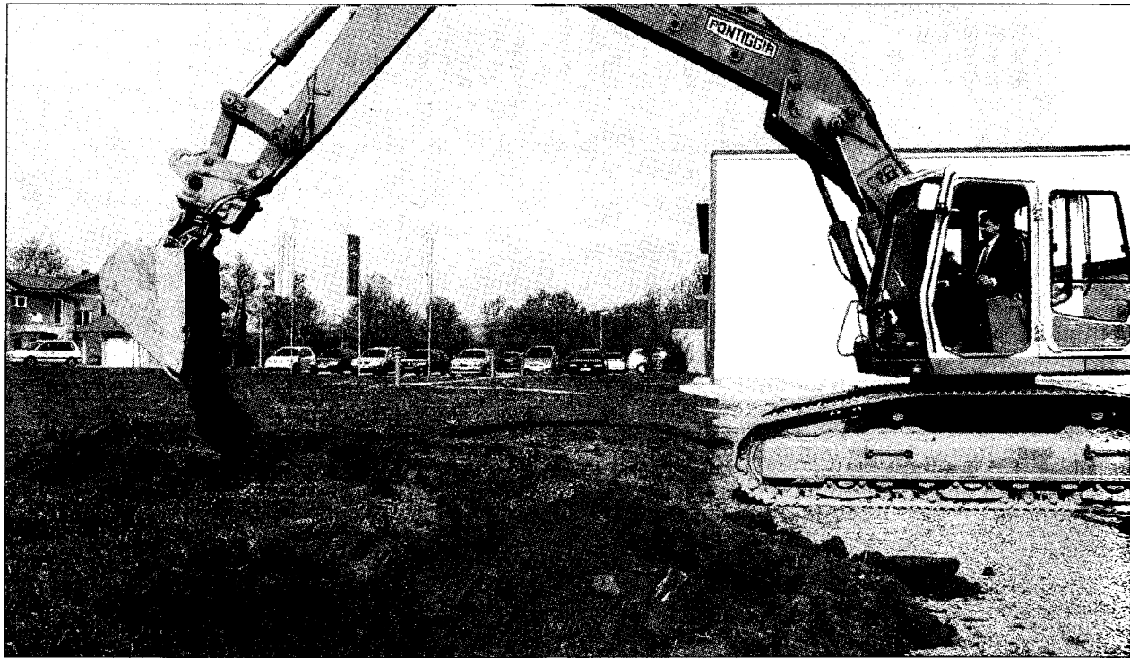
Die Bagger sind angerollt: Gestern begann die Erweiterung der Firma Sensopart in Gottenheim.
