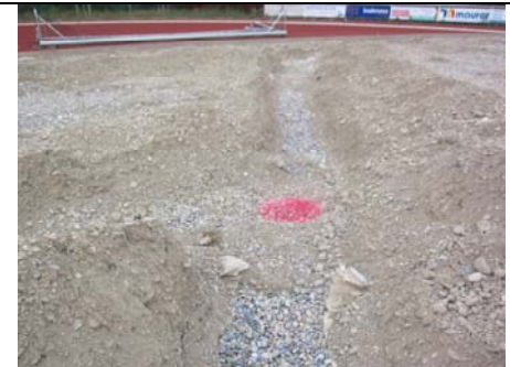
Bild 25: Freilegung Sauger Pkt. 15
