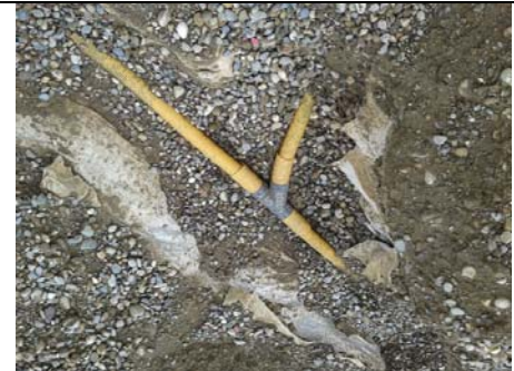
Bild 28: Freilegung Sauger Pkt. 15
