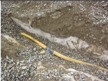
Bild 26: Freilegung Sauger Pkt. 6
