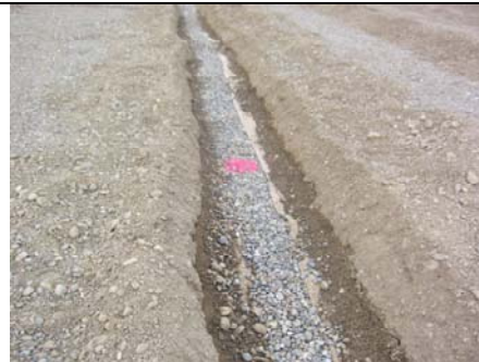
Bild 24: Freilegung Sauger Pkt. 3
