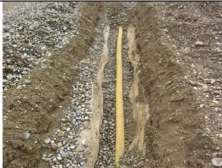
Bild 27: Freilegung Sauger Pkt. 3
