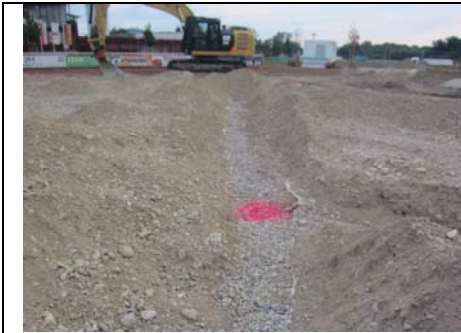
Bild 23: Freilegung Sauger Pkt. 6
