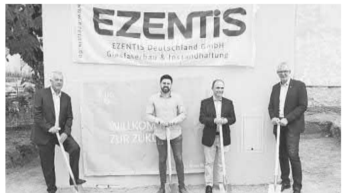
Am 30. Juli erfolgte mit dem ersten Spatenstich durch (von links) Marc Pauly (UGG), Alejandro González von der Baufirma Desigenia, Nicolas Dominguez-Staedke (Ezentis) und Bürgermeister Christian Riesterer der Start für den Glasfaserausbau.
