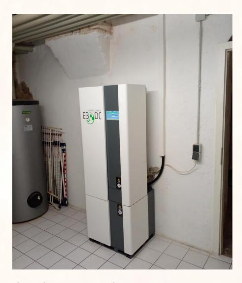
Wechselrichter und Batteriesystem (in einem Gerät kombiniert)
