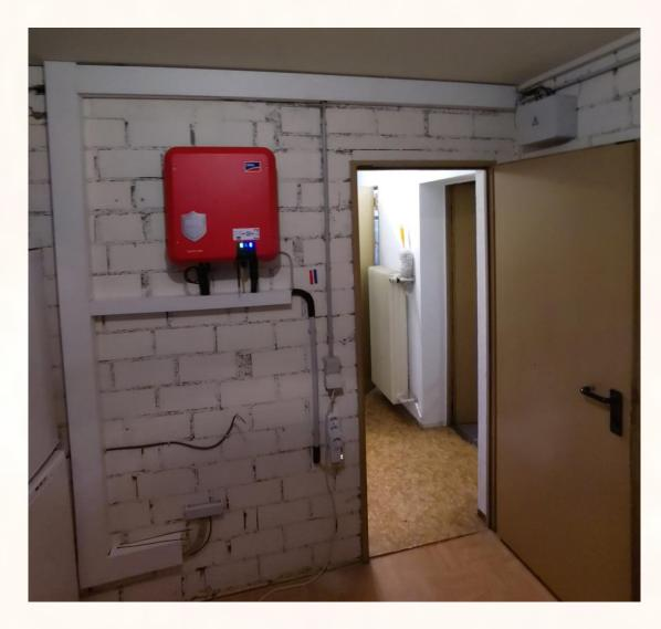
Wechselrichter (PV-Anlage ohne Speicher)
